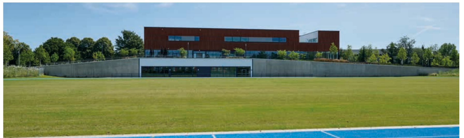
Verschieden gestaltete Aufenthaltsbereiche vermitteln zwischen den Sportanlagen
