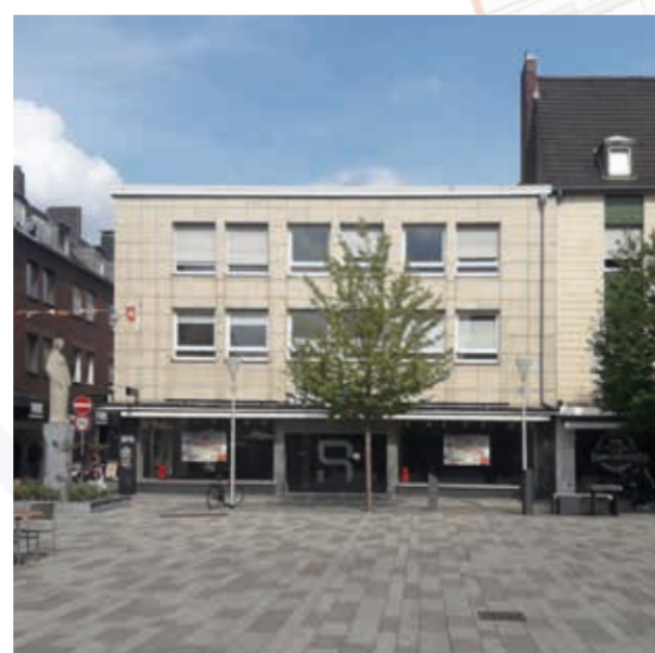
Markt 11: unvollendet ohne Dachaufbau
