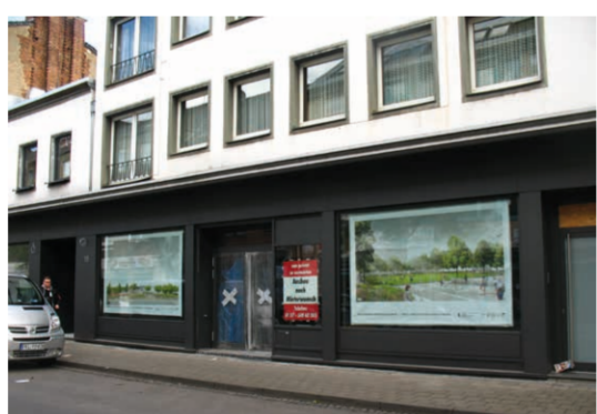
Schaufensterplakat während der Umbauphase
