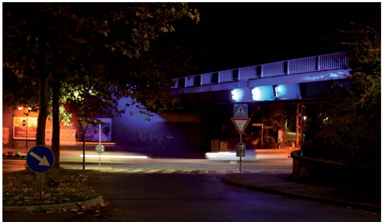
Probebeleuchtung am 05.11.2016: Bahnbrücken in der Josef-Schregel-Straße, Nordseite
