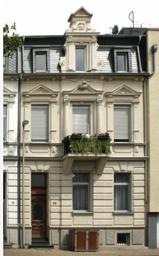
Fassade nach der Sanierung
